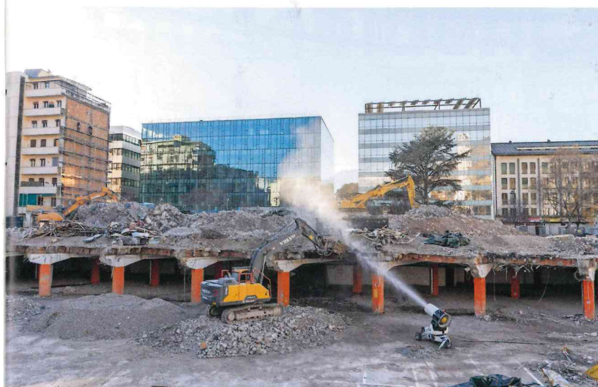
Abbruchbaustelle mit Wasser-Besprühung zur Staubbinderung.
